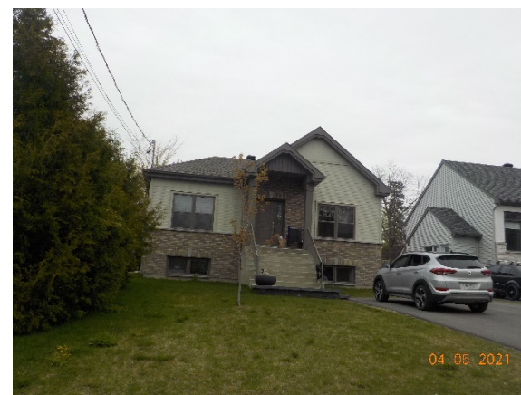
17, 46 e Avenue (voisin de droite)
